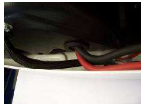
3. Faire passer les câbles par le trou, les faire sortir à l'intérieur de la cabine par la reprise d'air, et remettre le passe-fil en place. S'assurer de l'étanchéité du passe-fil
